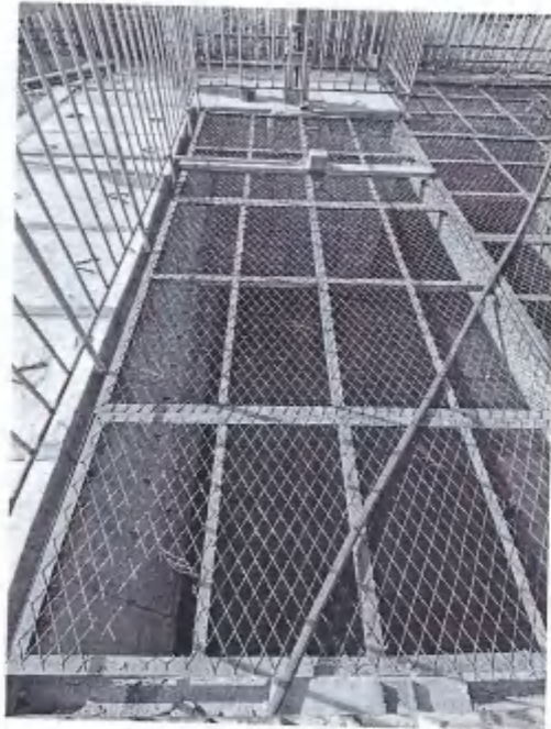
图 1: 污水进厂监测点位现场照片
